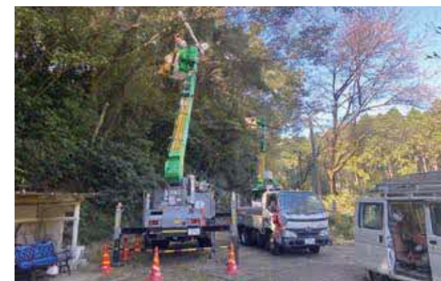
高所作業車を生かした高木剪定作業
