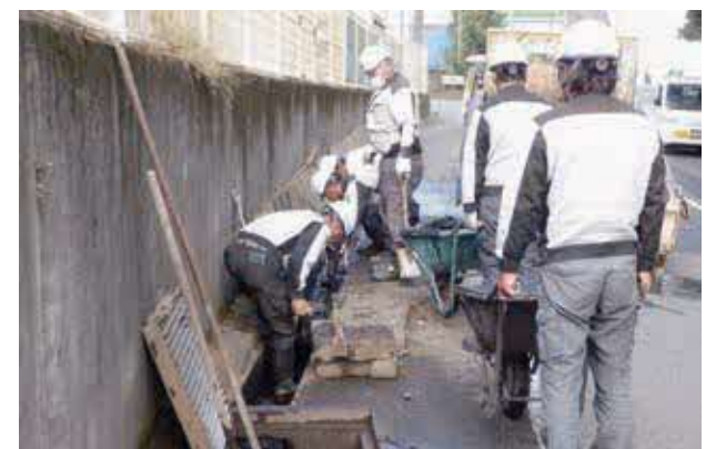
路肩や側溝に堆積した土砂をかき出す組合員
