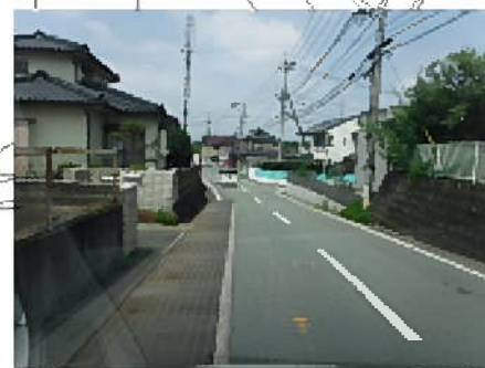
⑥鉄製蓋が連続し降雨時は滑る
