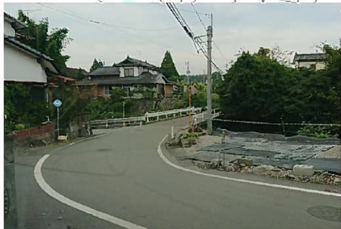
④幅員が狭く見通しが悪い
