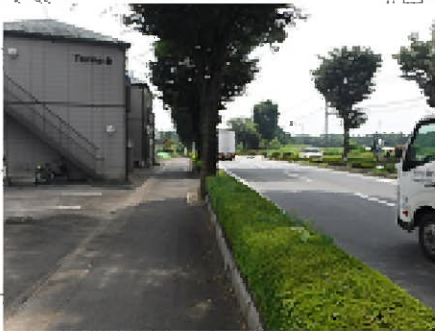
②降雨時には歩道が冠水する
