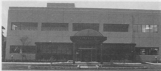
完成した浄化センター
