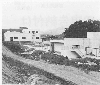
三月末の供用開始に向けて工事が進められる浄化センター
