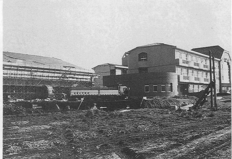
建設中の室小学校
