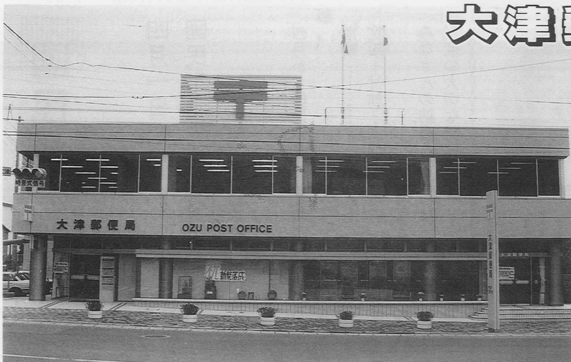
完成した大津郵便局局舎
