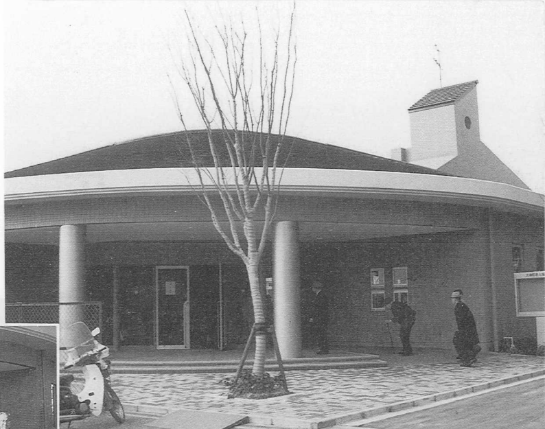
▲総工費約4億円をかけて町老人福祉センターが完成。 2月27日に落成式が行われ、現在では老人福祉の拠点として大いに活用されています。
