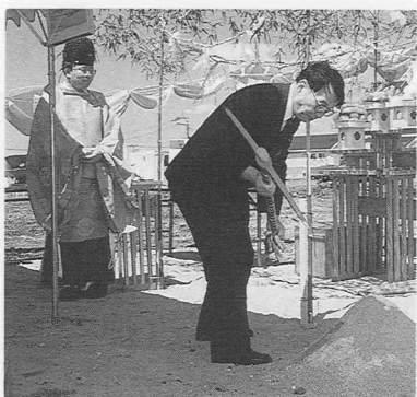
大津幼稚園起工式で くわ入れをする荒木町長
