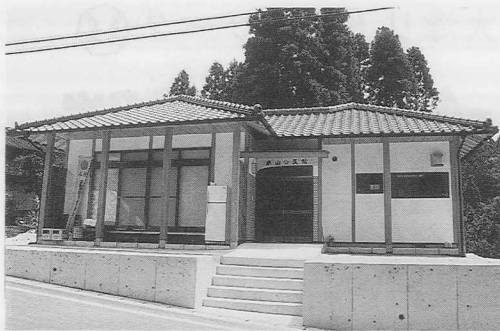
完成した米山公民館
