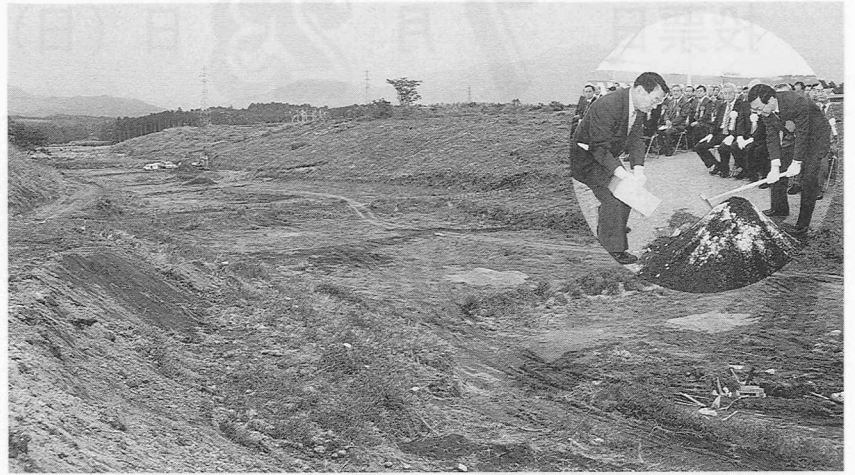
造成現場の風景(円枠内は起工式の様子)
