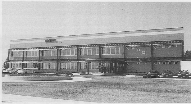
完成したテラダイイン(株)熊本事業所
