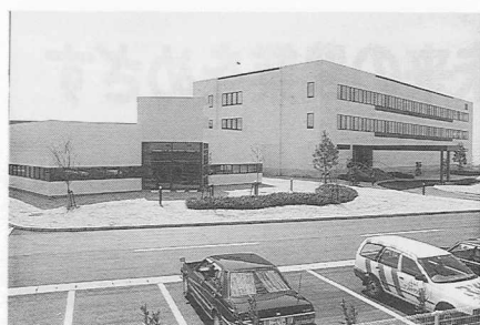
完成した東京エレクトロン九州 大津事業所の社屋
