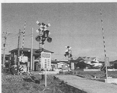
遮断機が設置された室の灰塚2号踏切
