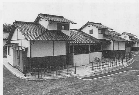
純和風づくりの町営矢護川団地
