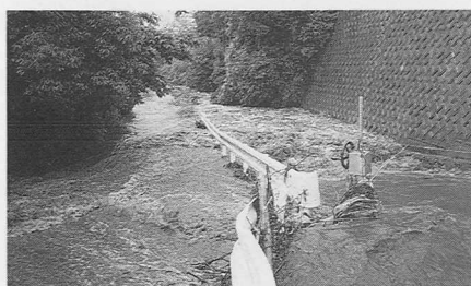
道路にあふれ出す上井手の濁流 (室地区) 7月9日
