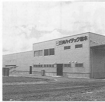
完成した第一工場棟
