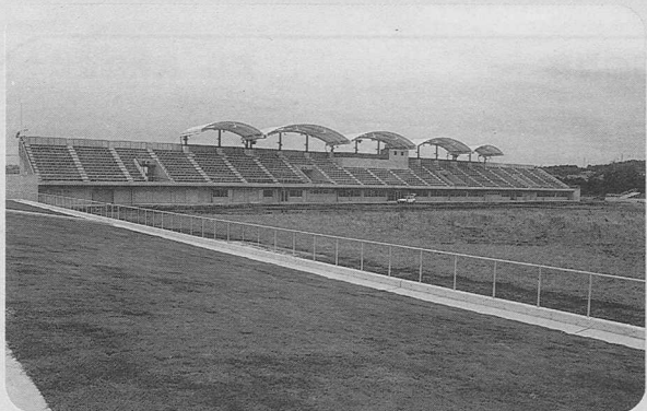
町運動公園(建設中)
