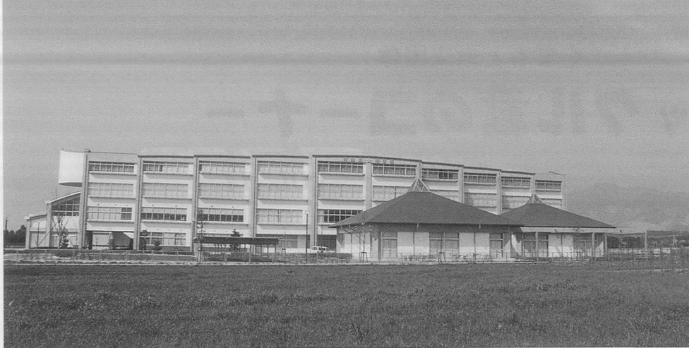
完成した大津北中学校の校舎
