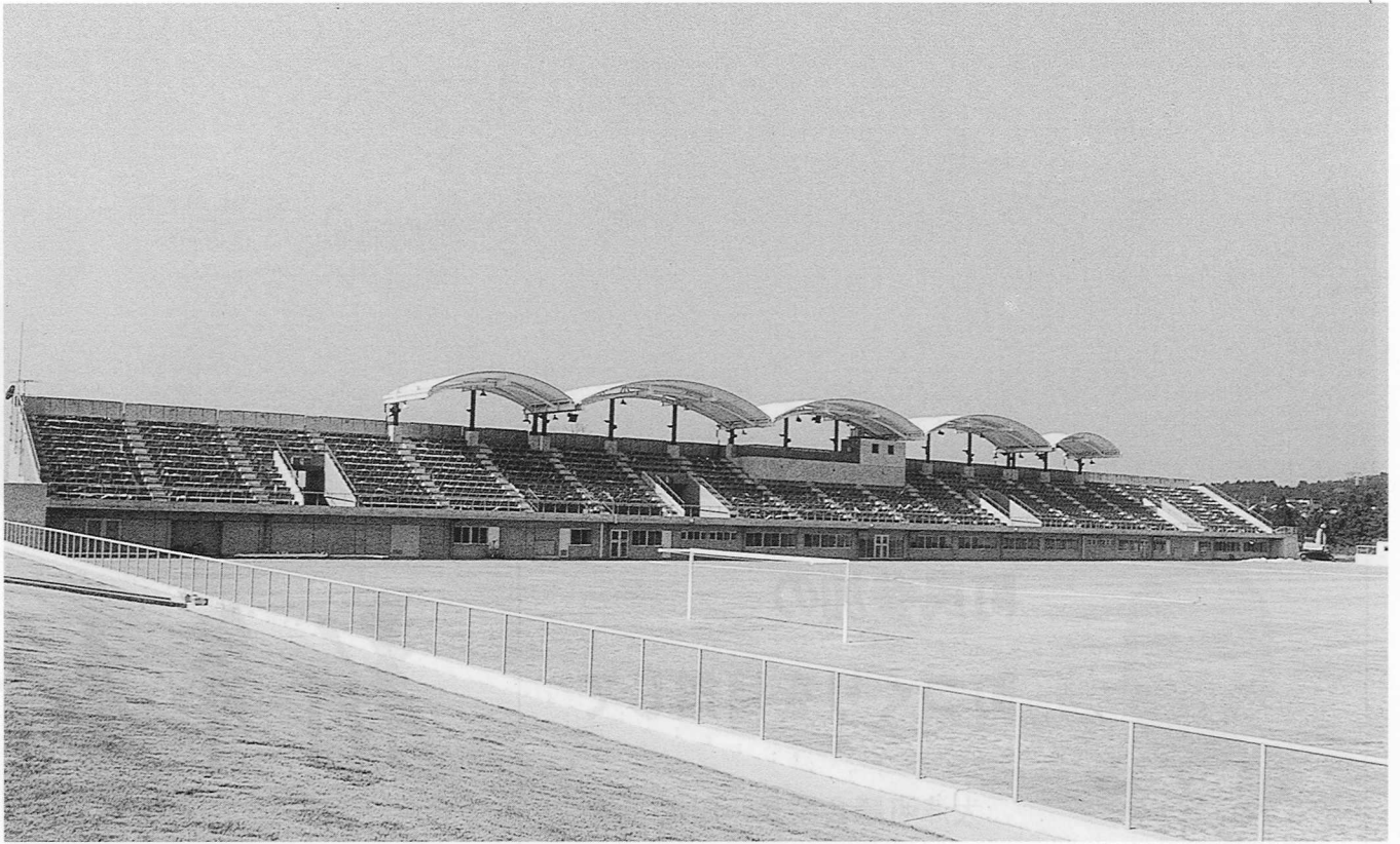
完成間近となった町運動公園球技場
