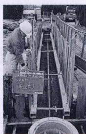
下水道管埋設工事の様子
