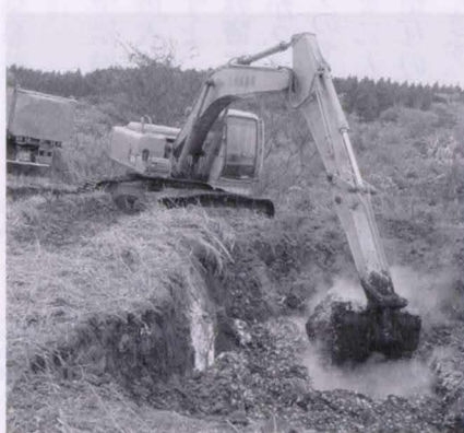
瀬田裏の撤去作業(11月14日撮影)
