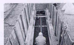
下水道工事(引水地区)
