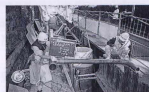
マンホール設置状況(矢護川地区)
