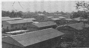
立石団地の東端に7月より 第1種9棟18戸を建設中でしが 11月6日に竣工し、新しい入居者もきまりました
