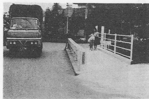
買物も安心です。—完成した窪口橋側道橋
