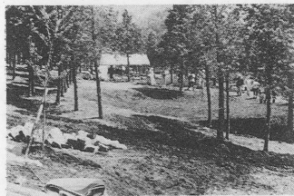
整備が進む隣の原キャンプ場
