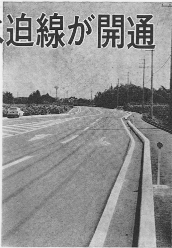
開通した18m4車線の町道・源場～水迫線
