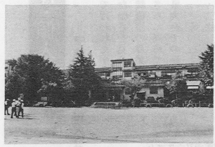
校舎増築工事が始まる大津小学校
