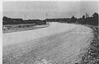
舗装される源場・水迫線 (325号バイパス～本田技研前)
