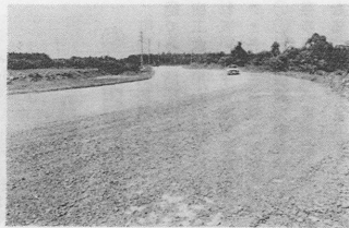
町道の新設・改良(源場・水迫線の18m道路)
