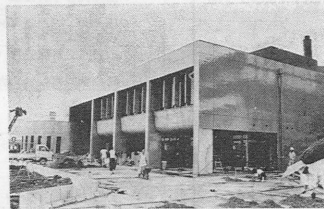
11月3日落成式めざして急ピッチの工事が進む集会所・公民館
