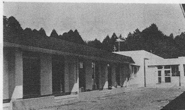
完成した老人ホーム「すぎなみ園」
