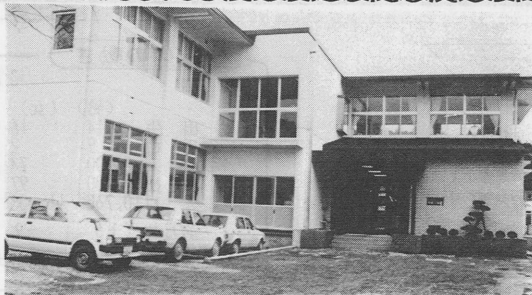
簡易保険の融資を受けて建設した真城小学校
