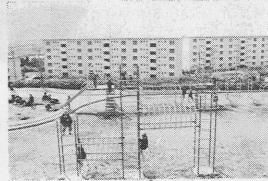
着々進む あけぼの団地建設
