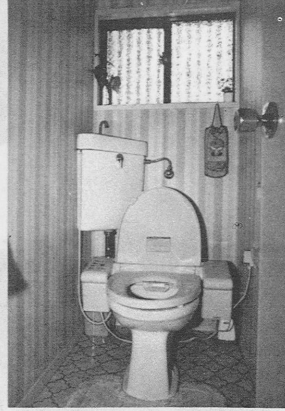
くみ取り式トイレを水洗式に改造
