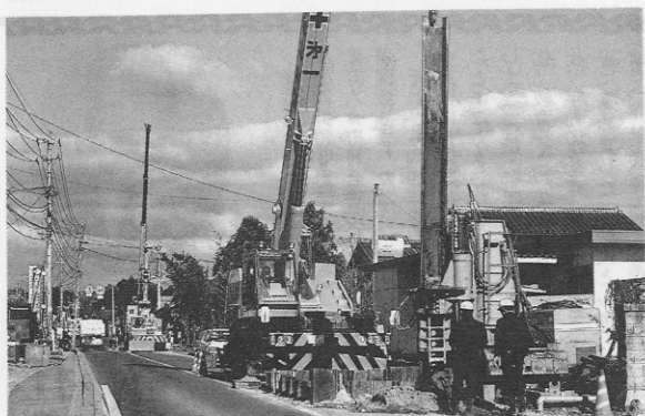
着々と進められる下水道工事（鍛冶村付近）
