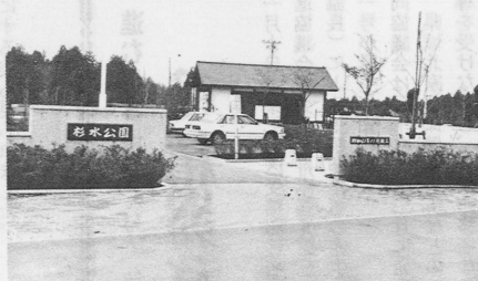
国道325号に面した正面入口
