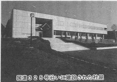
国道825号沿いに建設された社屋
