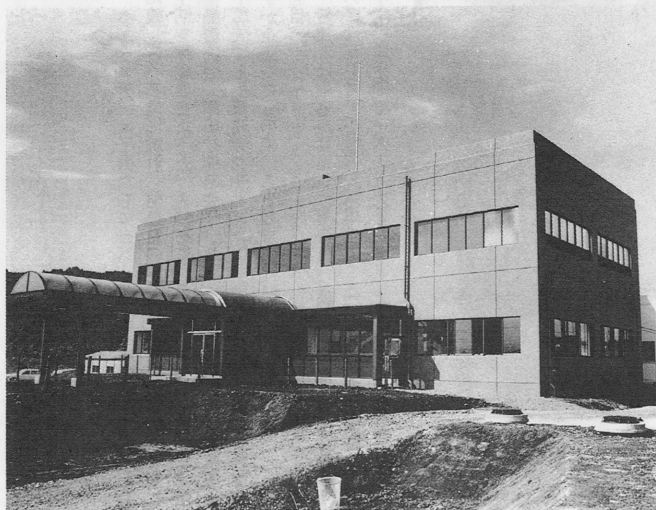
↑建設が進む浄化センター管理棟
