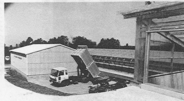
完成したフン尿処理施設
