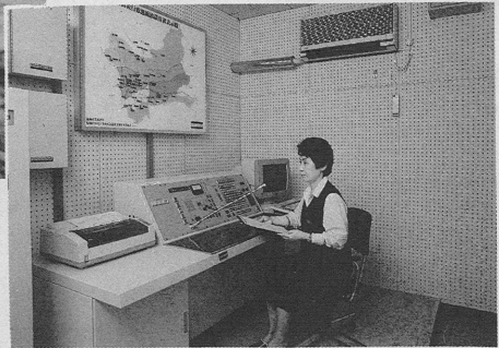
■操作卓(役場) 親局としての必要な機能をすべて用意。子局を一斉、個別、グループ別に選び、放送(定時と緊急)します。
