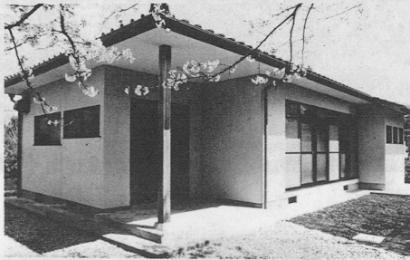
完成した新小屋集会所
