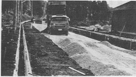
進む新小屋桜山線道路改良工事 (主な町税収入の内訳)
