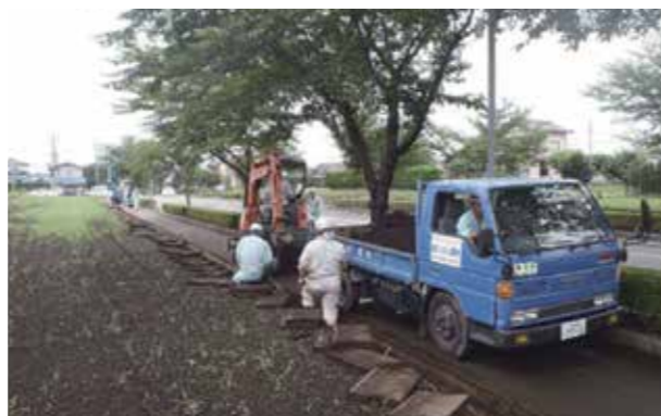
ボランティア作業(側溝内の土砂撤去)の様子
