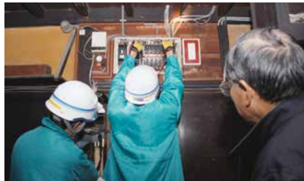
漏電が起きる可能性がないか、一つ一つ丁寧にチェックします
