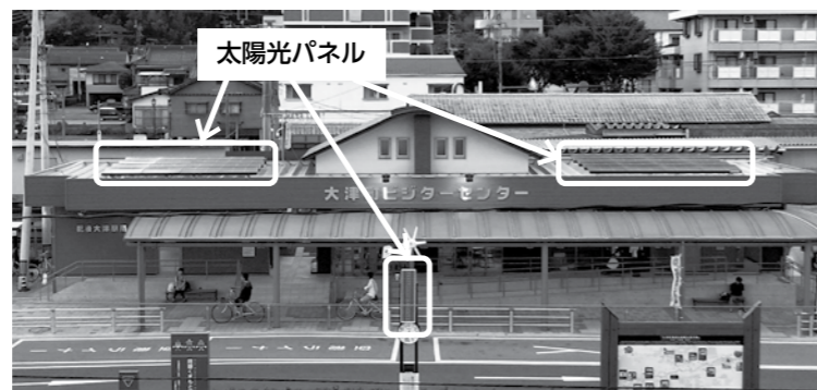
ビジターセンターの太陽光パネル
