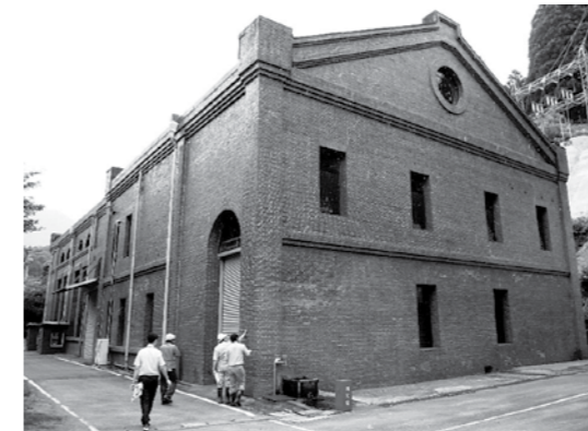
レンガ造りの「白川発電所」外観
