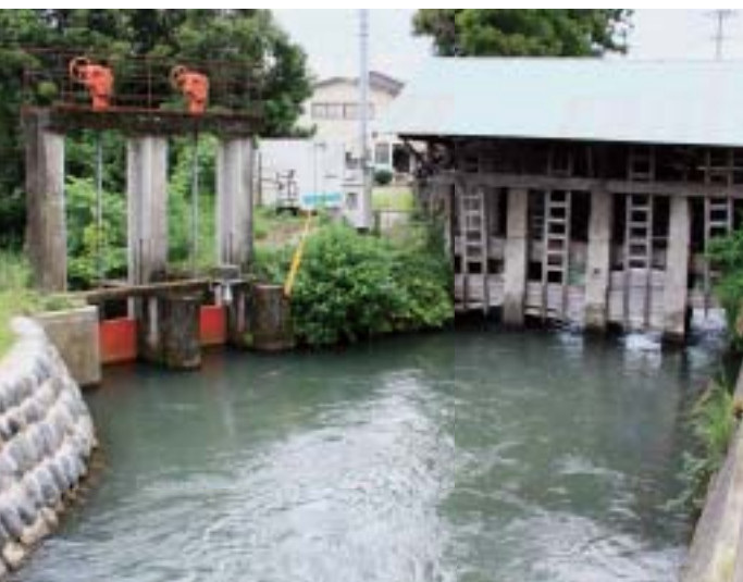
旧下井手の取水口
