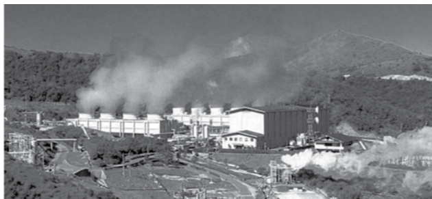
国内最大の地熱発電所「八丁原発電所」(出力110,000 kW)
