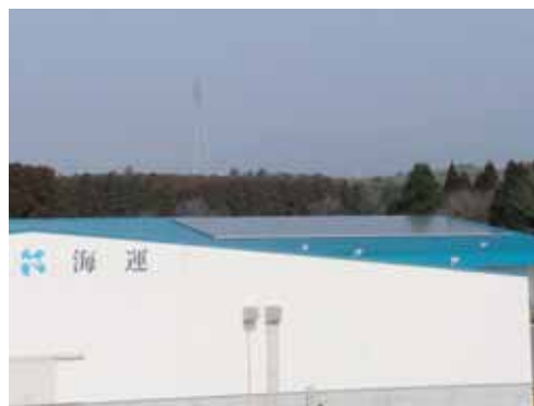
名港海運㈱熊本営業所に設置されている50KWの太陽電池住宅での太陽電池設置は3KWが多い
