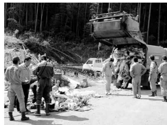
消防署の職員も出動し、現場検証を行っています
