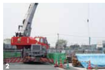
1_施設内の温泉に手を添える井上理事長 / 2_保育園の工事が始まりました
