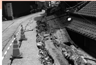
国道57号の阿蘇立野付近の土砂崩れで、現在県道北外輪山大津線（通称ミルクロード）が迂回路となっています。これに伴い町道三吉原北出口線や町道新小屋桜山線の通行量が急増し、路面の損壊が頻発しています。舗装の修復については国と県が行います。**【問い合わせ】**役場 建設課 ☎096-293-2815
