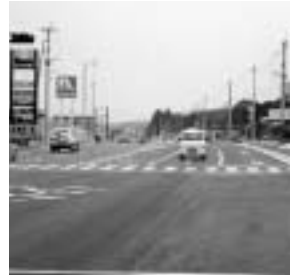
4車線に整備された吹田団地入口交差点
